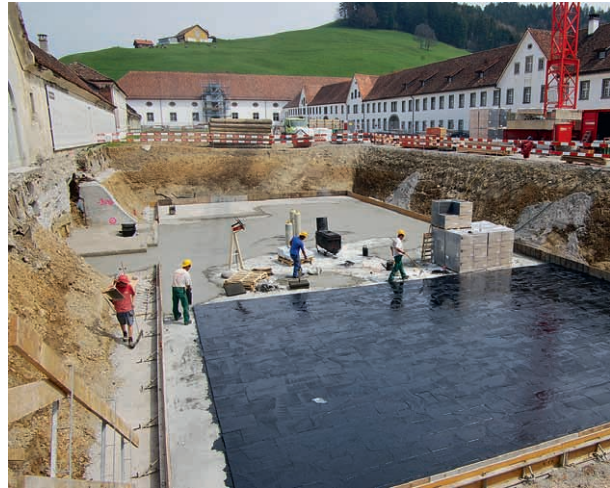
Die Baugrube, die rund einen Viertel des Statthaltereihofs einnimmt.
